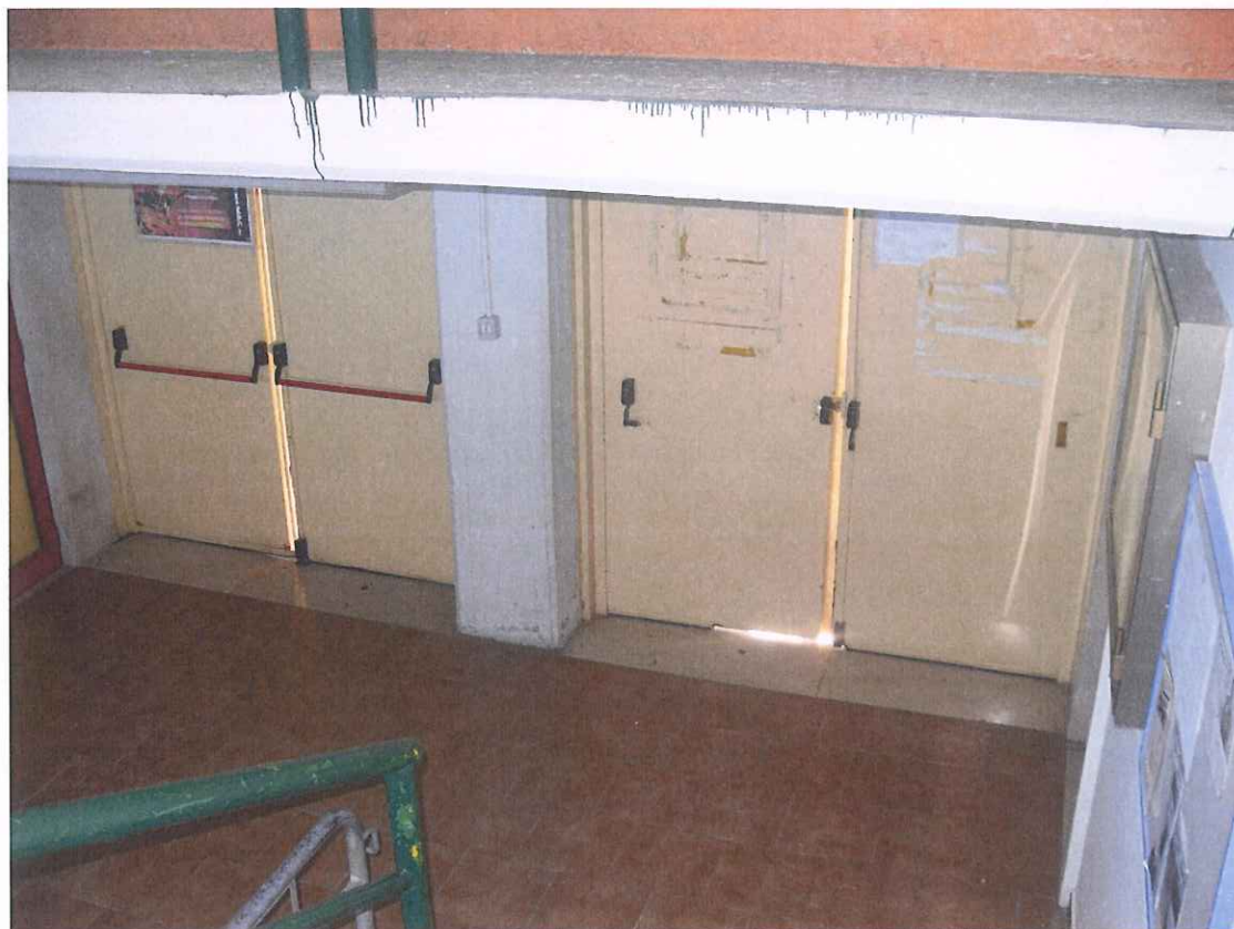
Particolare delle porte di ingresso/esodo oggetto di sostituzione
